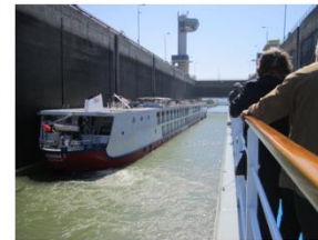
Djerdap I, 2. Schleusenteil
