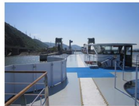
Schleuse Djerdap I / Eisernes Tor
