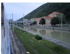
Schleuse Jochenstein vor Passau
