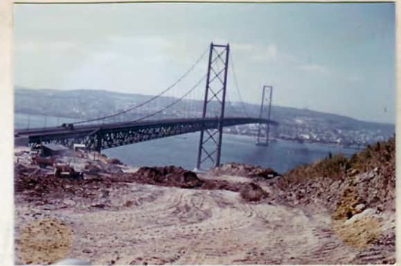
Le nouveau pont suspendu qui relie Lisbonne à l'autre rive du Tage. Il était alors encore en construction
